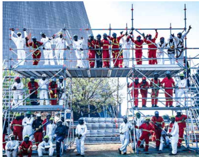
Elektrik santrali, Duvha, Güney Afrika
