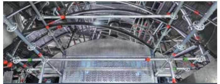
Buharlı kazanlar içindeki iskele için yuvarlak platformlar
