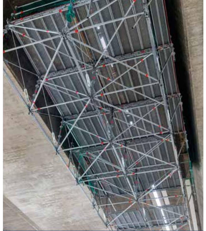
Allround kafes kirişler kullanılarak mobil asılı iskele
