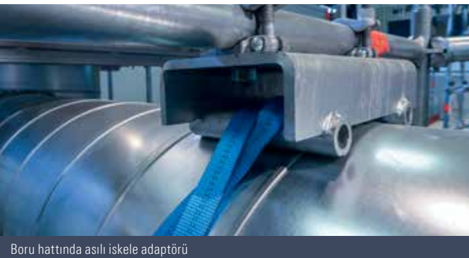
Boru hattında asılı iskele – asılı iskele adaptörlü zincirler kullanılarak takılır
