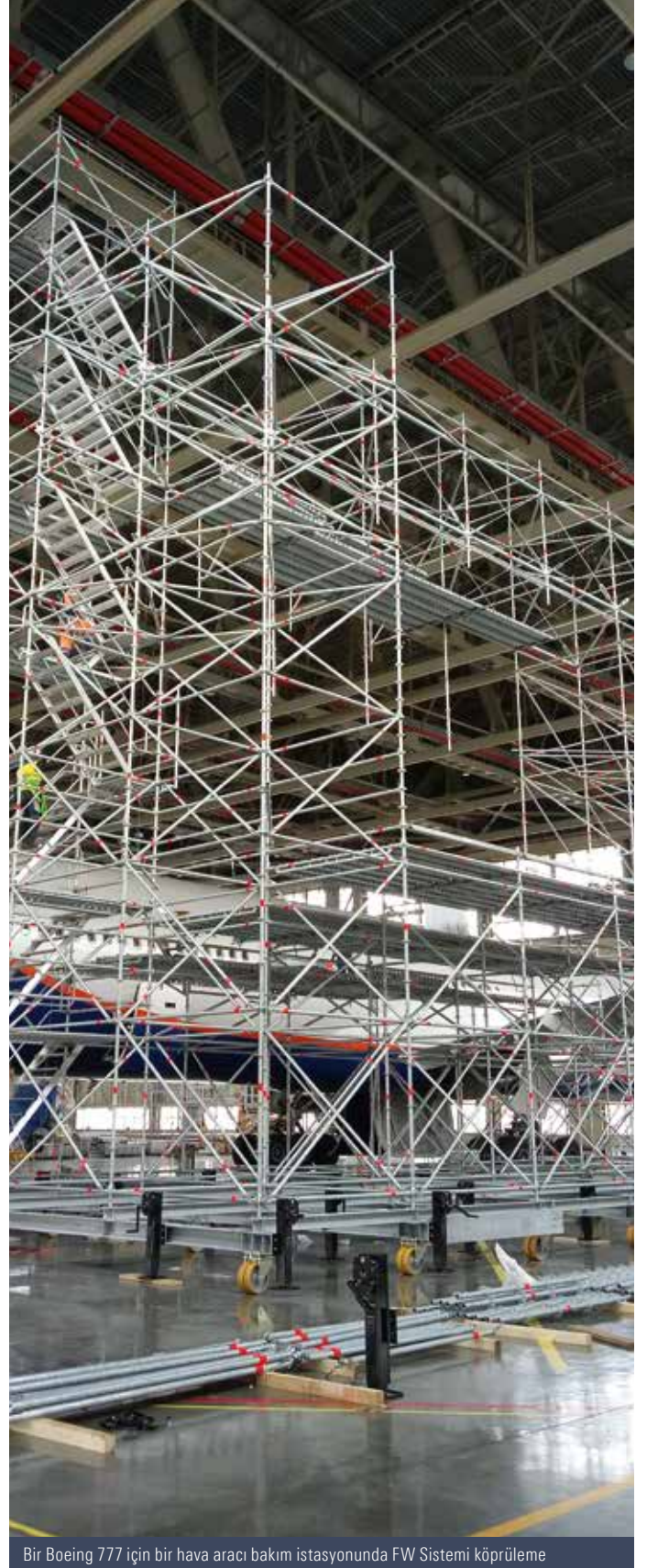
Bir yapının içindeki Allround FW Sistemi ile hacimli kafes iskele – zemin alanı serbest kalır ve normal çalışmanın devam etmesini sağlar
