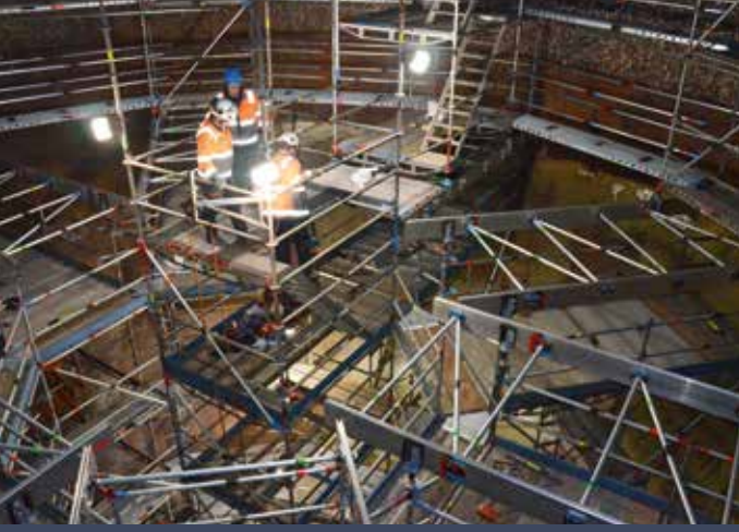
Buhar kazanı içindeki iskele için Alüminyum FlexBeam ile köprüleme
