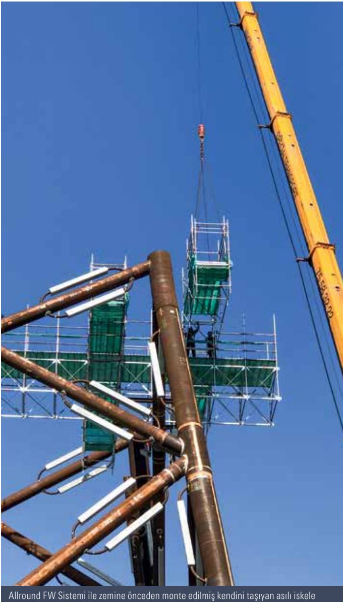
Vinç konumlandırması sırasında Allround Köprüleme Sistemi ile zemine önceden monte edilen yaya köprüsü
