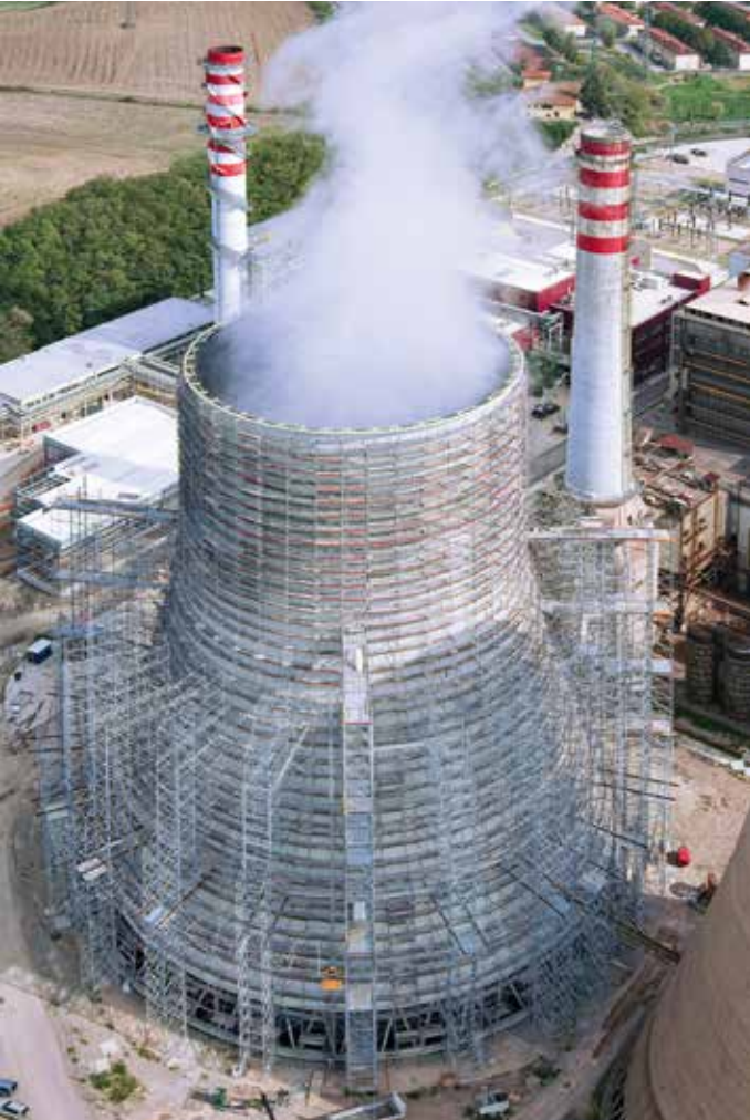
Elektrik santrali, İtalya
