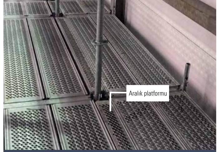
Geçiş noktasını konsol yüzeylerine kapatmak için kama başlı sistem aralık platformları
