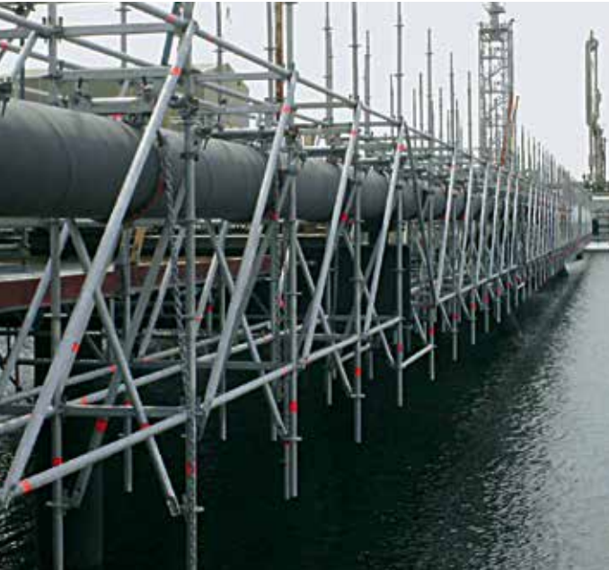
Boru hattında asılı iskele – asılı iskele adaptörlü zincirler kullanılarak takılır
