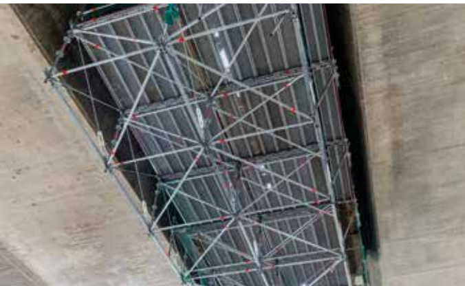
Allround FW Sistemi ile mobil asılı çalışma platformu
