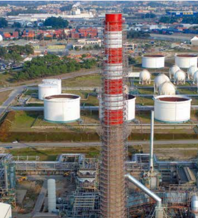
Rafineri kolonunda Allround İskele ile dairesele iskele
