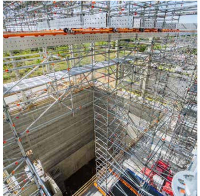
Yeni bir endüstriyel tesis inşa ederken Alüminyum FlexBeam ve Allround FW Sistemi ile birlikte Allround TG 60 taşıyıcı iskele
