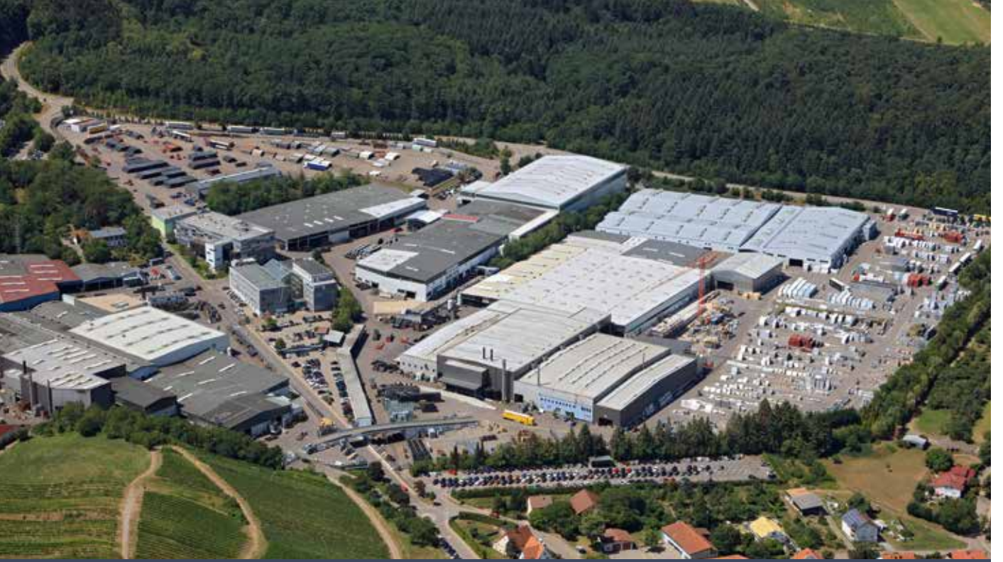
Layher'in Güglingen-Eibensbach'taki ana tesisi
