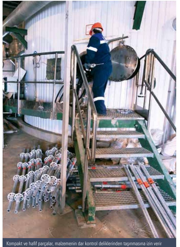
Buharlı bir kazan içerisinde iskele için Merdiven Kulesi 200
