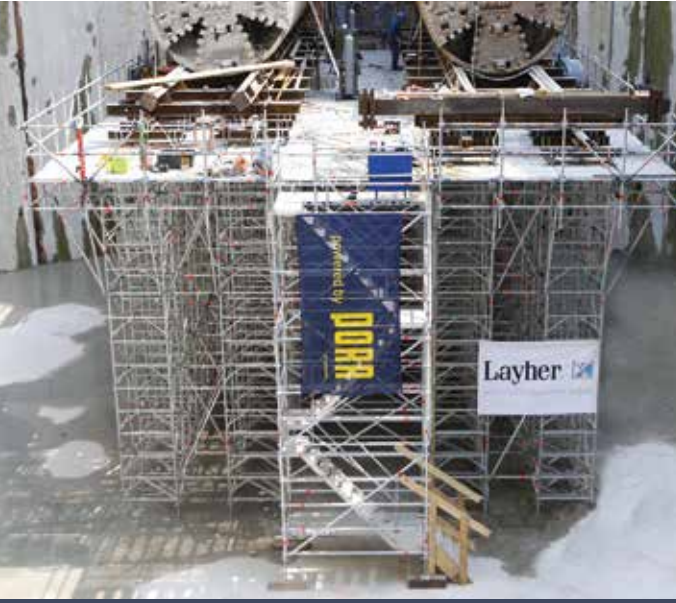
Matkap kafalarını ayarlamak için entegre platform merdivenli Allround TG 60 Taşıyıcı İskele'den yapılmış yük platformu
