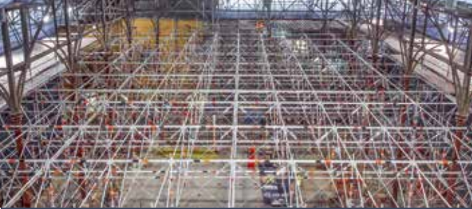
Bir yapının içindeki Allround FW Sistemi ile hacimli kafes iskele – zemin alanı serbest kalır ve normal çalışmanın devam etmesini sağlar
