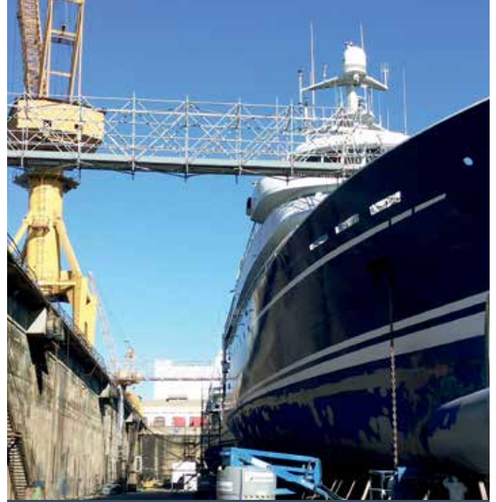
Allround standart parçaları kullanarak köprüleme
