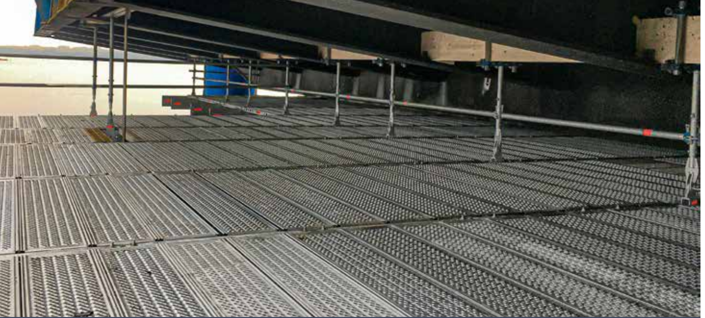
Standart çelik platformlarla tripsiz ve aralıksız platform
