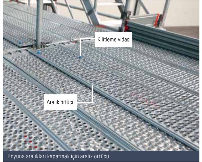
Geçiş noktasını konsol yüzeylerine kapatmak için kama başlı sistem aralık platformları
