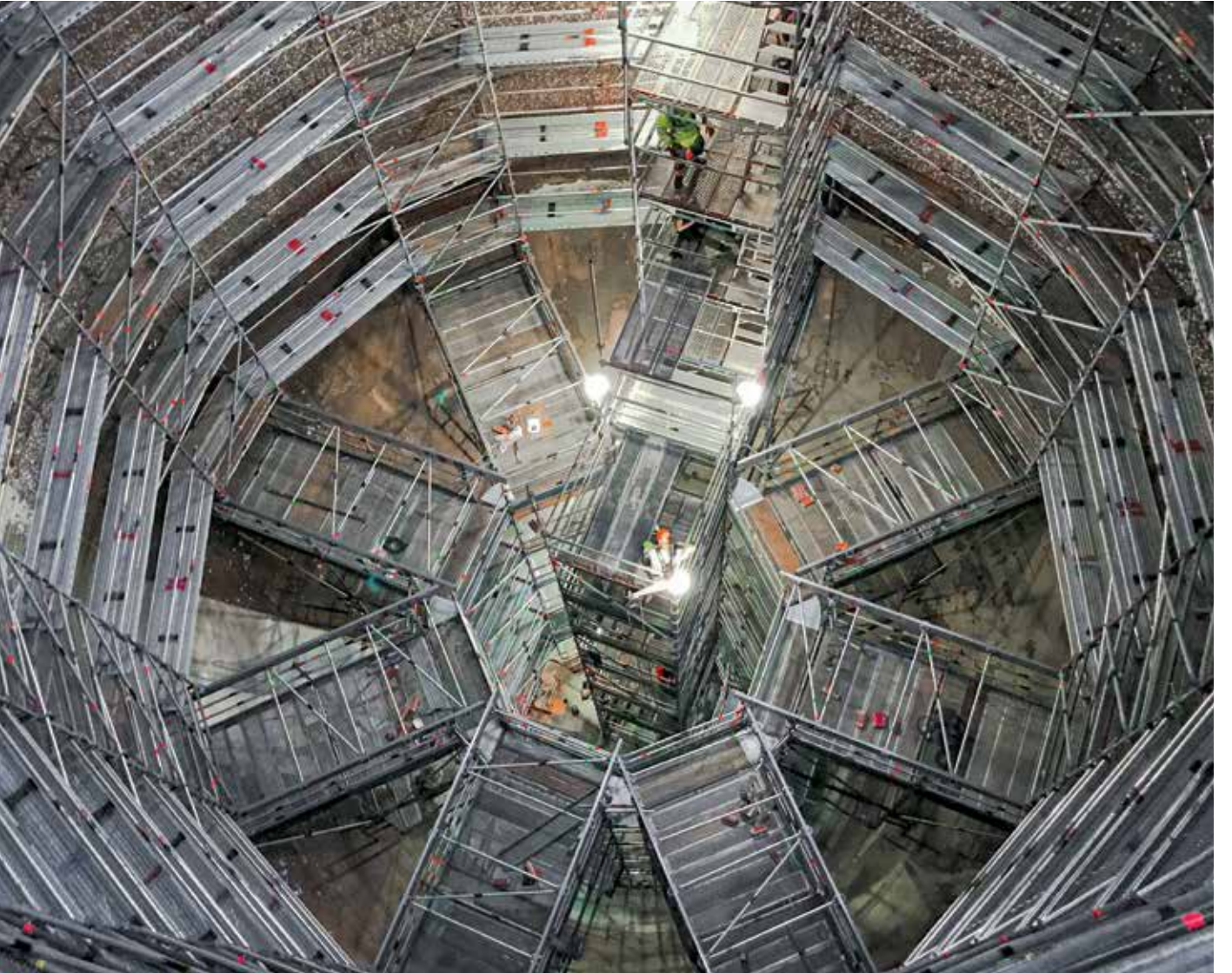
Alüminyum FlexBeam ile buhar kazanı içerisindeki iskelenin tam görünümü
