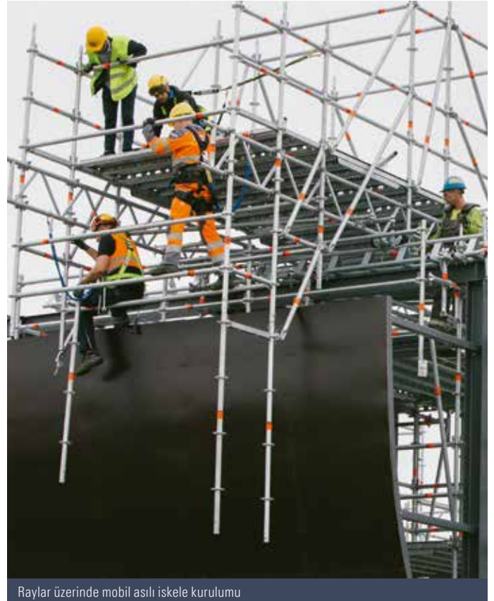
Allround kafes kirişler kullanılarak mobil asılı iskele
