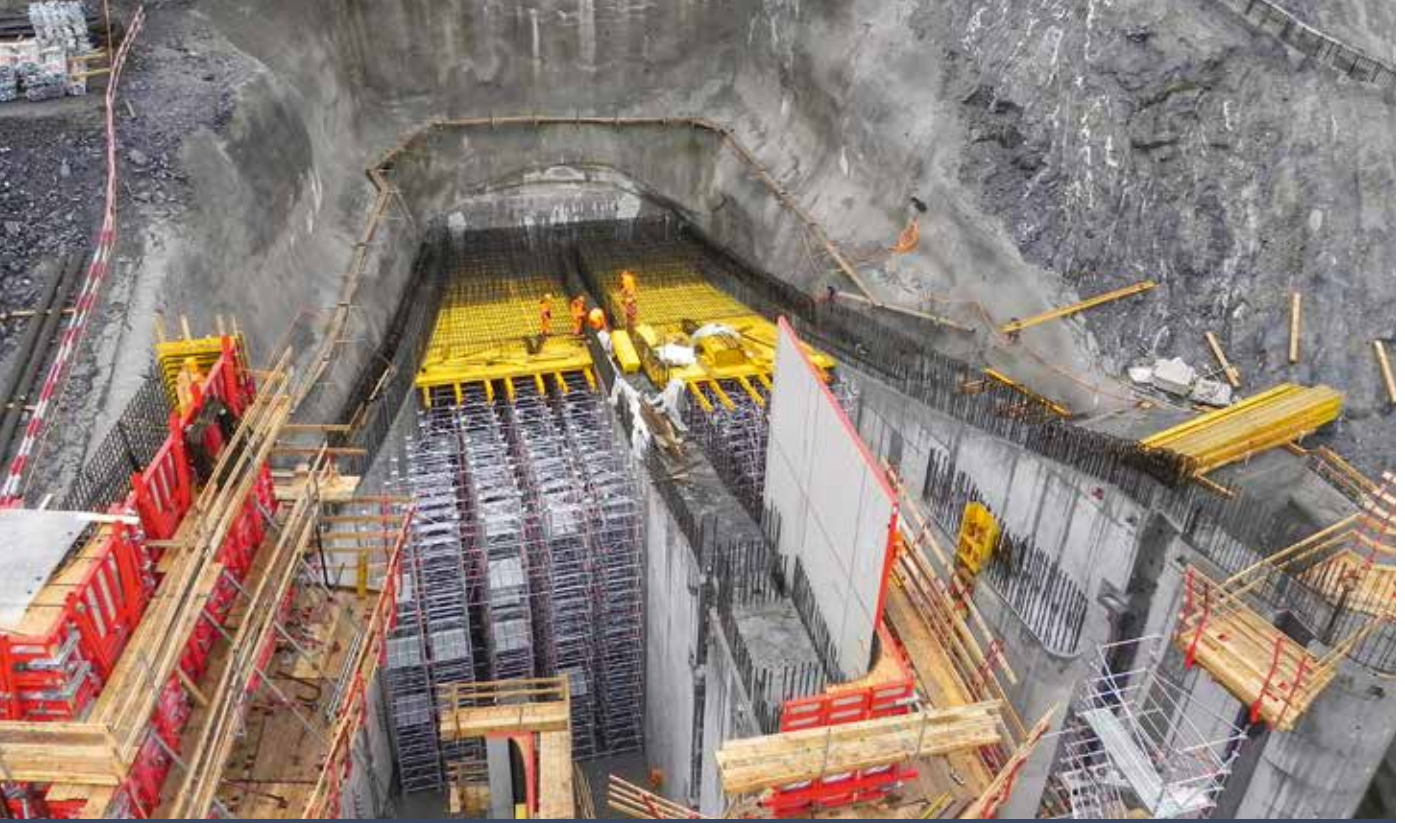
Pompalanmış bir depolama elektrik santralinin bir çıkış bacasında Allround TG 60 taşıyıcı iskeleyi desteklemek
