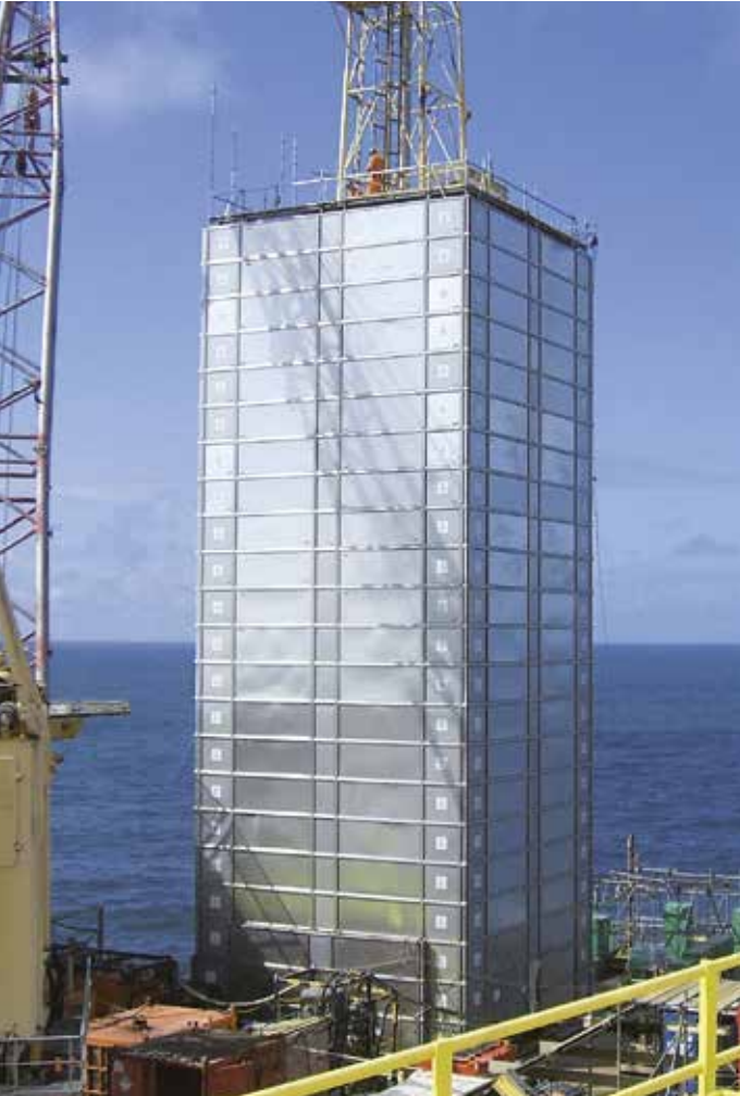
İrlanda kıyılarında petrol sondaj platformu
