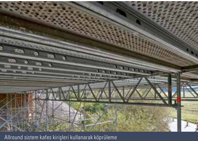
Layher aksesuar sınıfından 450 LW Çelik Sistem Kafes Kirişlerle Köprüleme
