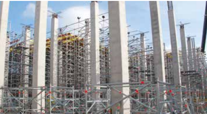
Yeni bir kanalizasyon arıtma tesisi inşa etmek için Allround TG 60 taşıyıcı iskele
