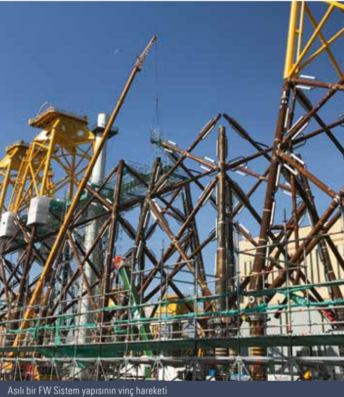
Konsol yöntemini kullanarak Allround İskele
